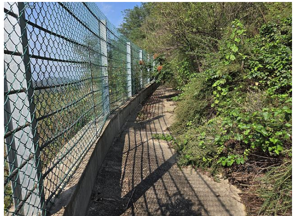
2소단 배수로 전경
