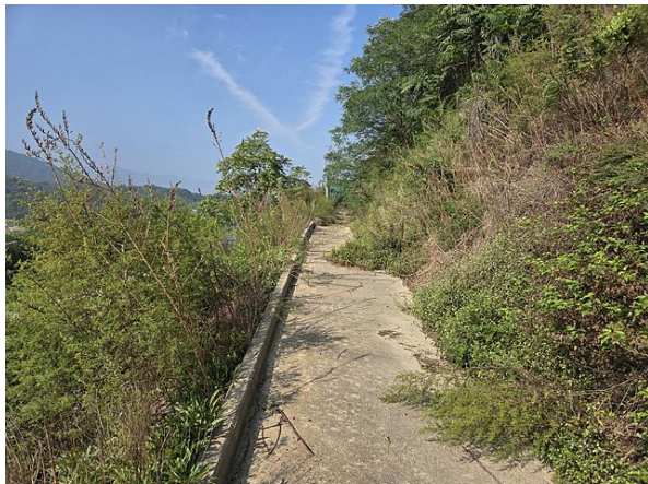
1소단 배수로 전경
